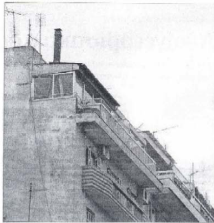
Μεγάλος αριθμός αυθαιρέτων ανήκει σε πολυνοσηλεύειες, οι οποίες αγοράσαν εκτάσεις εκτός σχεδίου και κτιριακό και έκτισαν κατοικίες. Ήδη, στην περιοχή των Μετεώρων της Πολέως, όπου ανεγέρθηκαν συνολικά 322 αυθαιρέτες κατοικίες, εντάχθηκαν στην τρίτη φάση επίταξης του σχεδίου πόλεως.
