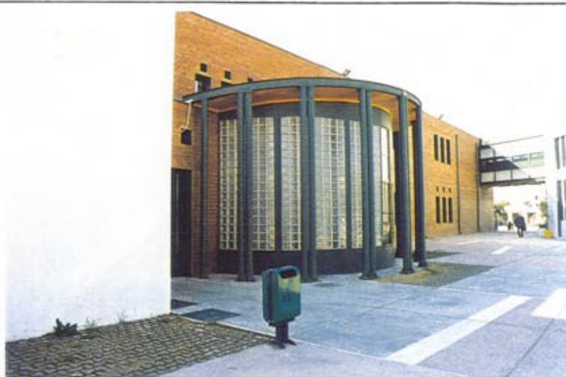
ΤΟ ΚΤΙΡΙΟ ΤΟΥ Β/Ν ΣΤΑΘΜΟΥ ΤΟΥ ΔΕΝΔΡΟΠΟΤΑΜΟΥ ΜΕΤΑ ΤΗΝ ΟΛΟΚΛΗΡΩΣΗ ΤΩΝ ΕΡΓΑΣΙΩΝ ΚΑΤΑΣΚΕΥΗΣ ΤΟΥ
