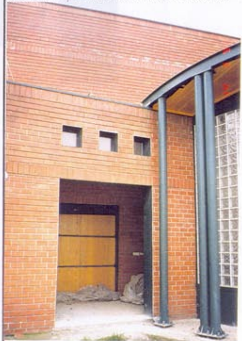
ΛΕΠΤΟΜΕΡΕΙΑ ΤΗΣ ΕΙΣΟΔΟΥ ΤΟΥ Β/Ν ΣΤΑΘΜΟΥ
