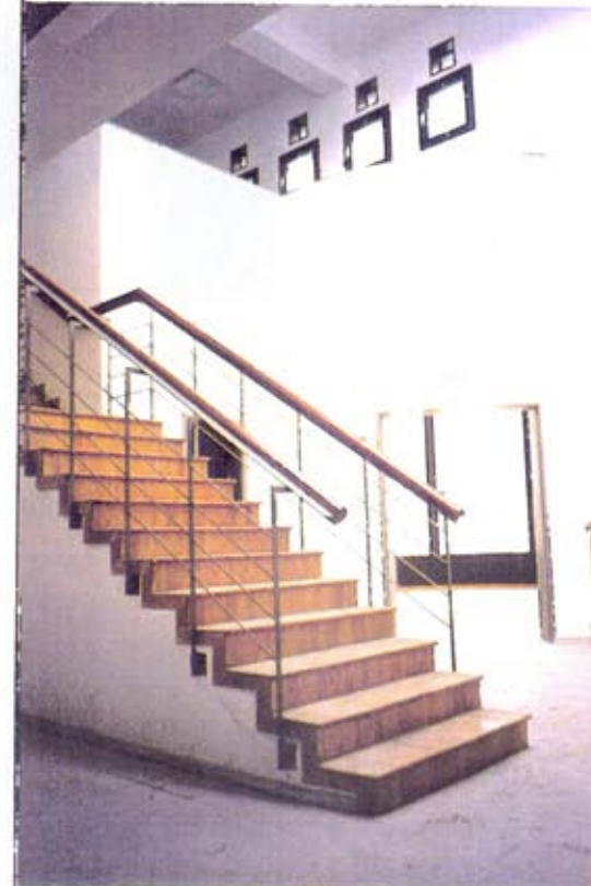
ΕΥΛΙΝΗ ΚΛΙΜΑΚΑ (ΣΚΑΛΑ) ΣΤΟ ΑΙΘΡΙΟ ΤΟΥ Β/Ν ΣΤΑΘΜΟΥ
